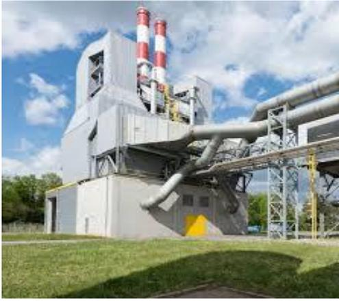
**Le traitement catalytique (SRC)** des oxydes d'azote (NOx) et des dioxines furanes, mise en service en novembre 2010, permet d'abattre la teneur en NOx dans les fumées à des valeurs inférieures à **80 mg/Nm3**.
