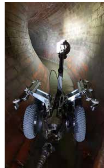
Inspection avec caméra de contrôle vidéo télécommandée
