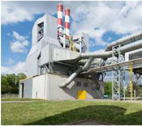
**Le traitement catalytique (SRC)** des oxydes d'azote (NOx) et des dioxines furanes, mise en service en novembre 2010, permet d'abattre la teneur en NOx dans les fumées à des valeurs inférieures à **80 mg/Nm<sup>3</sup>**.
