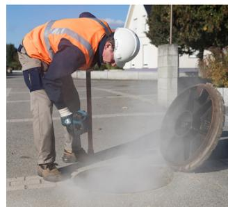
Il s'agissait dès lors de faire un état des lieux très précis des raccordements d'eaux pluviales au réseau d'eaux usées. Un test simple a été mis en place pour repérer rapidement les anomalies : de la fumée (inoffensive) a été insufflée dans le réseau des eaux usées dans la rue des habitations testées, afin d'en détecter les raccordements
