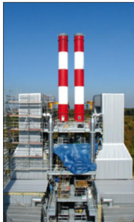
Différentes étapes des travaux : la construction du nouveau bâtiment en béton armé, la mise en place des échangeurs de chaleur et des réacteurs catalytiques, la pose des deux nouvelles cheminées.
