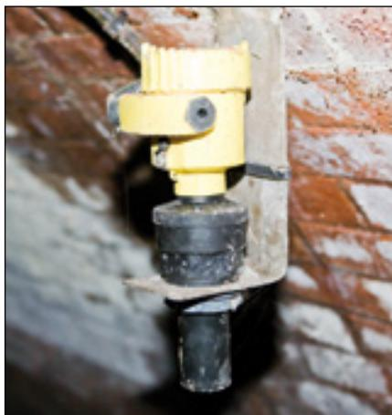
Appareil de mesure mis en place dans un déversoir d'orage.
