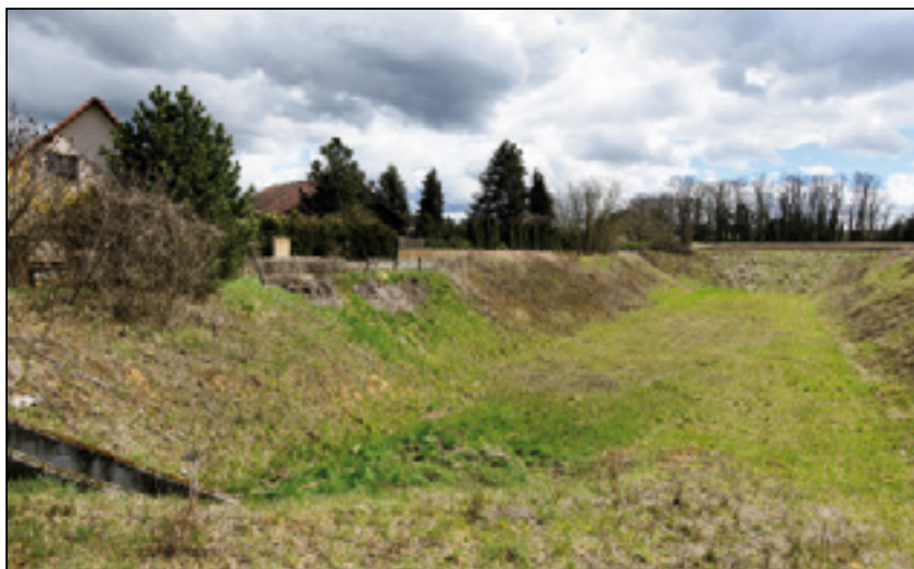
Le bassin de rétention rue de Riedisheim à Rixheim est doté d'une capacité de 6 000 m 3 . Le terrassement a nécessité l'évacuation de 12 500 m 3 de terre. Les travaux ont duré 2 mois.
