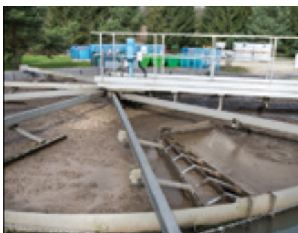
Épaississement des boues dans un bassin flottateur
