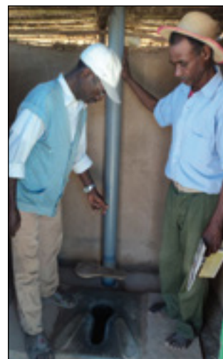
Installation d'une latrine
