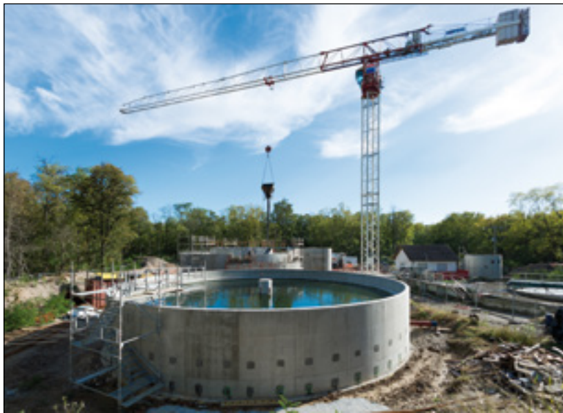
Travaux de génie civil et tests d'étanchéité des bassins
