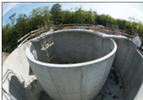
Travaux de génie civil et tests d'étanchéité des bassins
