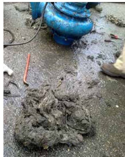
Curage de réseau obstrué par des lingettes.
