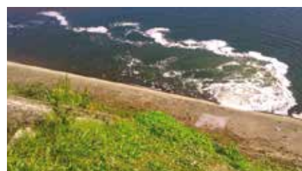
Les eaux épurées suivent un canal dédié pour se jeter dans le Grand Canal d'Alsace.
