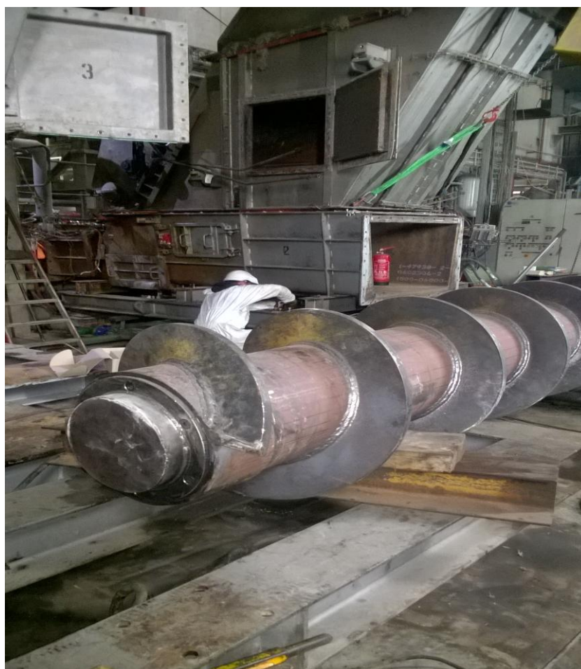
Travaux effectués en octobre 2015 sur ligne 2
